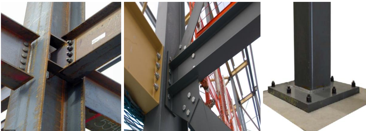
Fig.6.1. L'assemblage dans les constructions métalliques.
