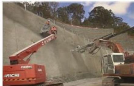
Figure 3.7. Ecran fonctionnant par clouage
