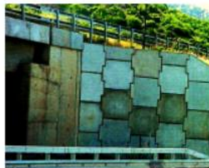
Figure 3.16. Exemple de remblai en terre armée
