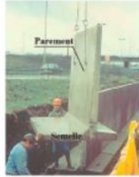
Figure 3.4. Mur fonctionnant par encastrement
