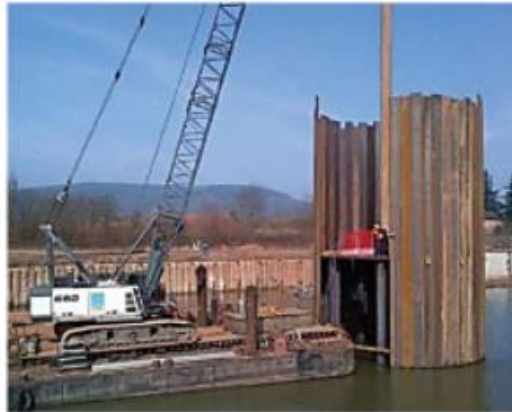
Figure 3.18. Exemple de batardeau en palplanches
