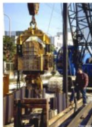
Figure 3.17. Exemple d'installation d'un rideau de palplanches (Site : île de Rokko, Japon)
