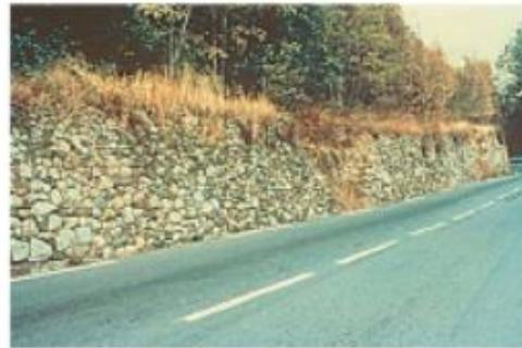
Figure 3.15. Exemple de mur à enrochement (Source R. Frank, 2012)
