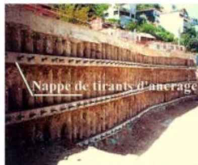
Figure 3.6. Ecran fonctionnant par ancrage (Paroi moulée ancrée)
