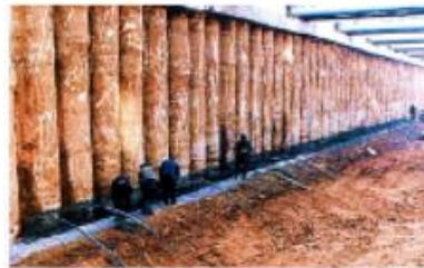
Figure 3.5. Ecran fonctionnant par encastrement (Paroi moulée auto-stable)
