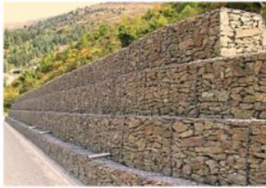
Figure 3.14. Exemple de mur en gabions (Source R. Frank, 2012)
