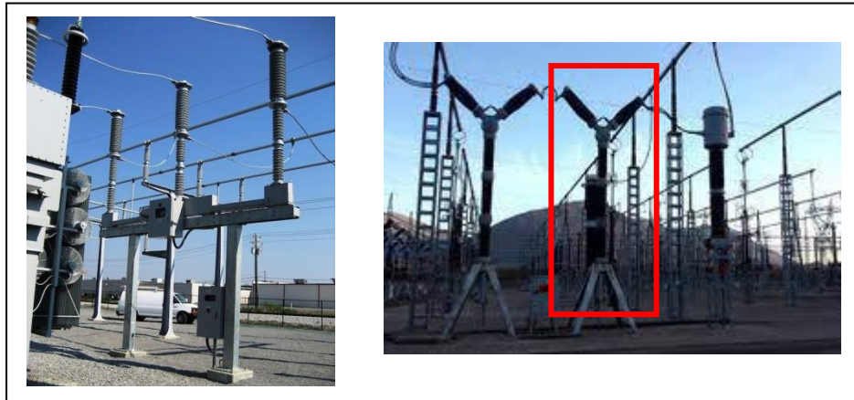
Figure I.12. Disjoncteur à haute tension
