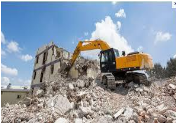
Déchets de démolition.
