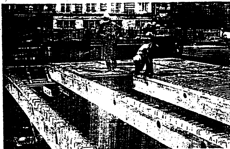
Poutrelles précontraintes à fils adhérents pour bâtiment (portée 11 m) avec prédalles en béton armé 5 (Immeuble AGF, Paris, 1977).
