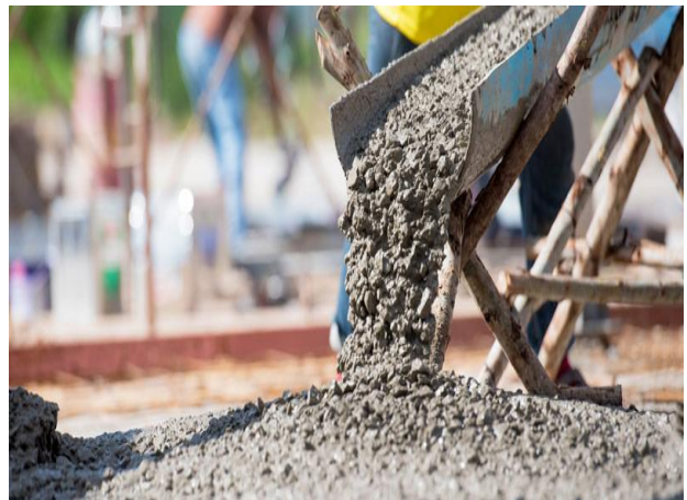
Figure 5.1. la mise en place du béton frais
