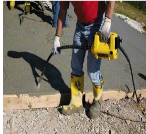
Figure 14. La vibration à l'aide d'une aiguille vibrante béton.
