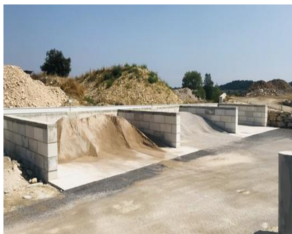
Figure 4. Stockage des granulats dans les grands chantiers
