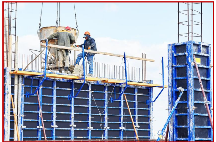
Figure 8. Le coulage d'un poteau ou voile en béton
