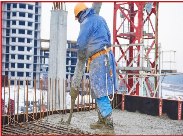
Figure 7. Le coulage d'une dalle de béton
