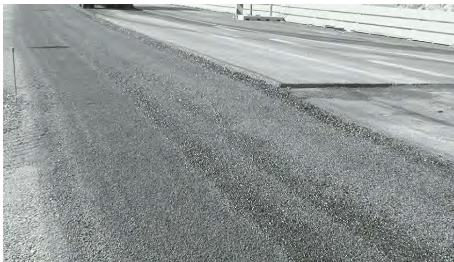
Figure 1.3 Vue rapprochée de la couche d'imprégnation sur la grave non traitée (GNT 0/20).
