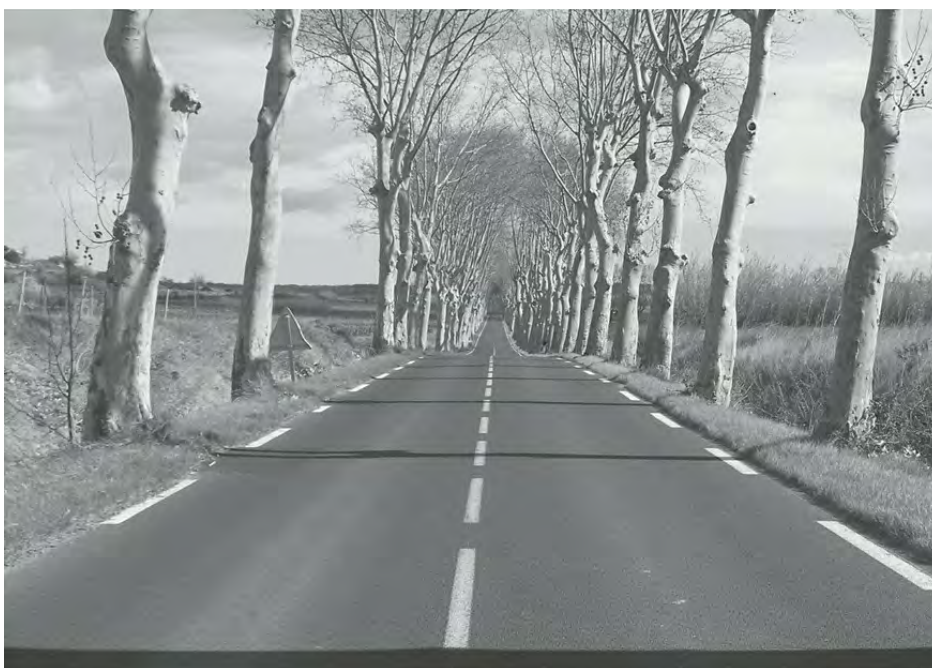
Figure 7.2 À éviter : alignements d'arbres qui jouxtent la chaussée. Il n'y a pas de zone de sécurité. « La route ne pardonne pas. »
