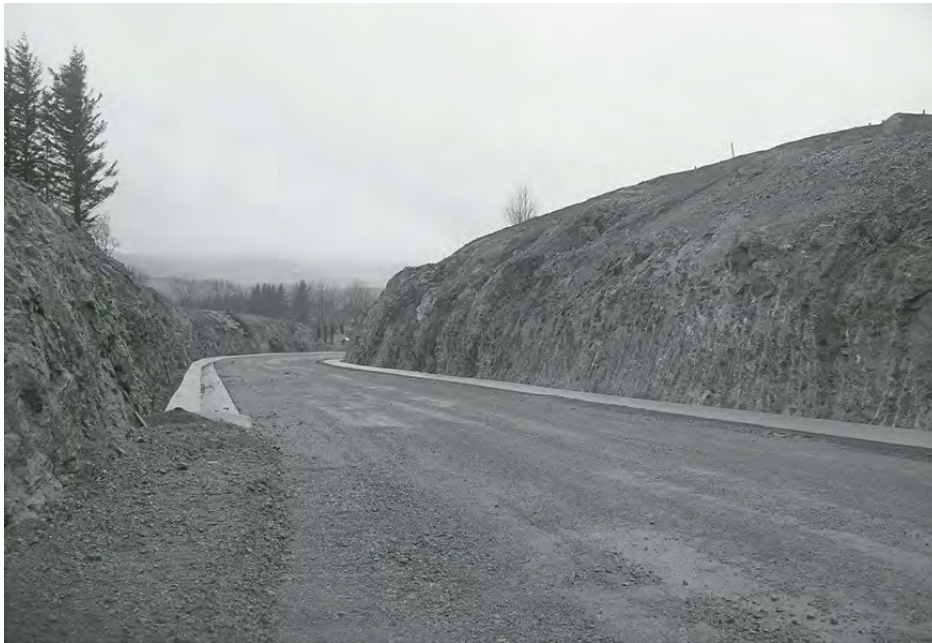
Figure 2.1 Aménagement d'une cunette en pied de talus de déblais.
