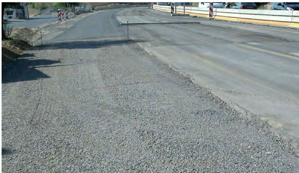
Figure 1.2 Réalisation d'une protection superficielle sur une couche de réglage.
