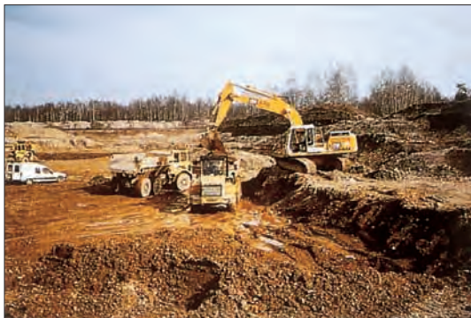
Extraction après rabattement de la nappe
