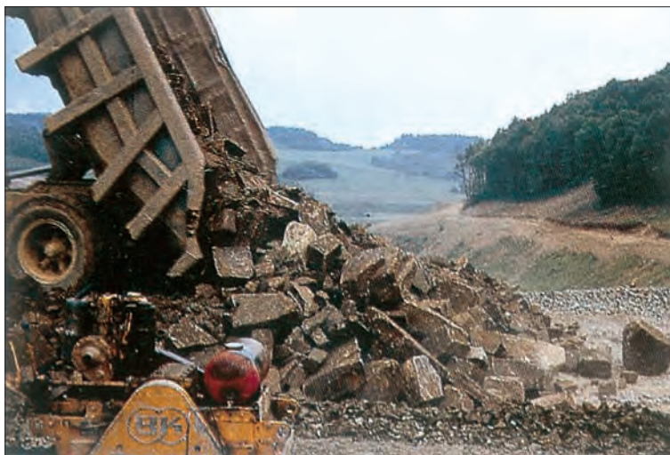
Roche magmatique dure (basalte) de classe R_{61}
