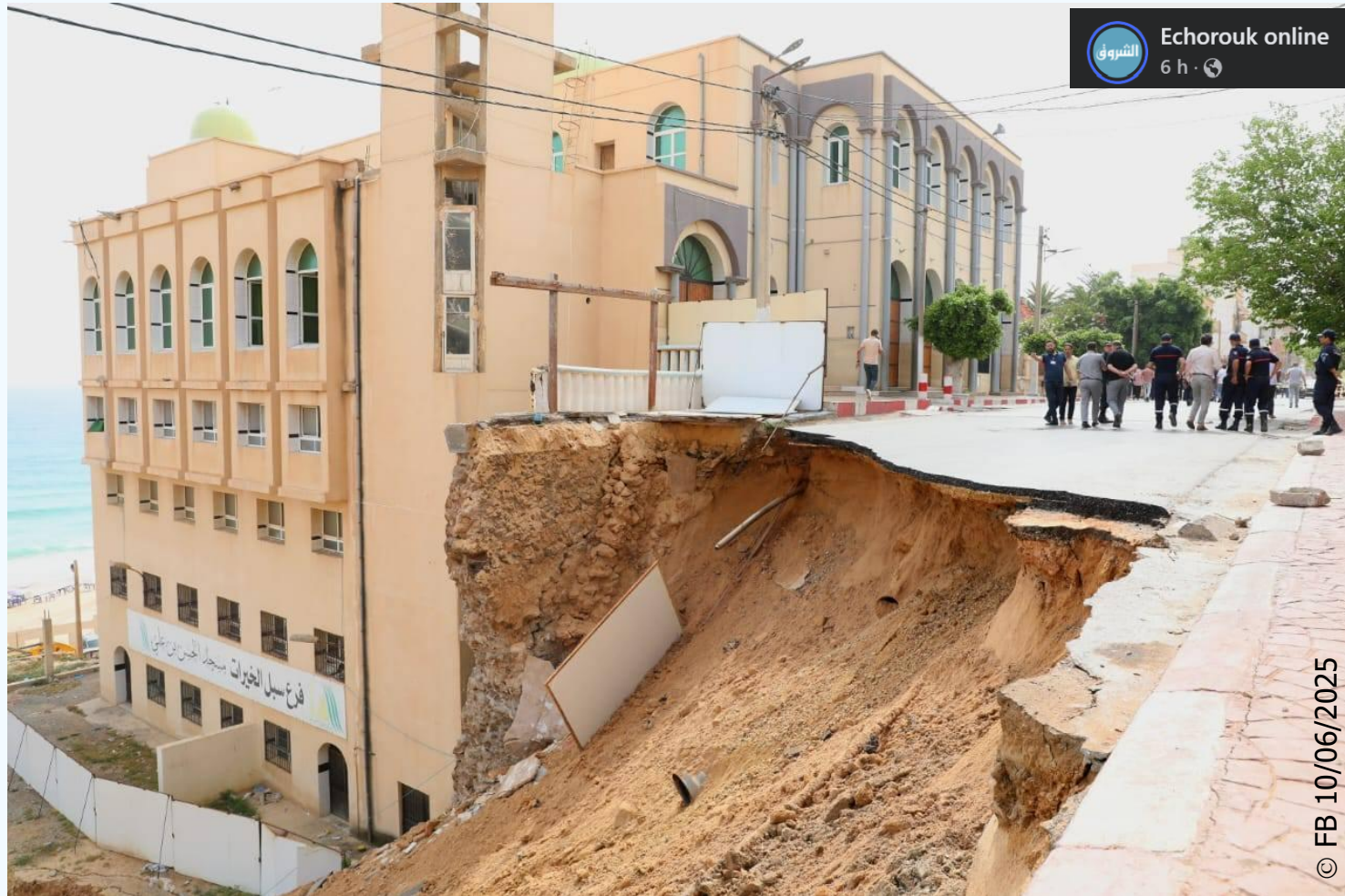
Glissement de terrain d'Ain Turck, Oran (10/06/2025)
