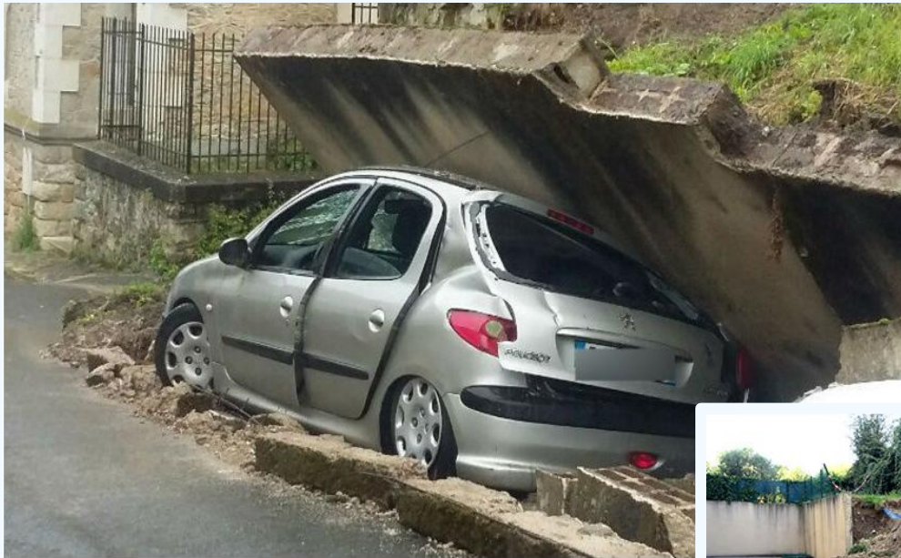
Une voiture écrasée par l'effondrement d'un mur de soutènement © Radio France - Marie-Ange Lescure
