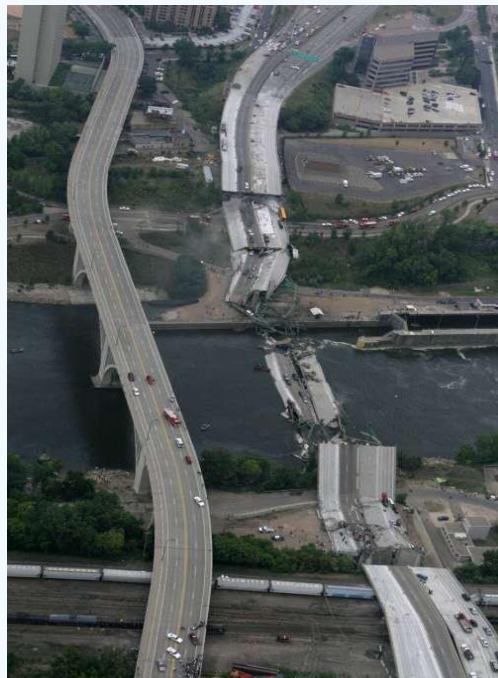
Structures en béton armé
