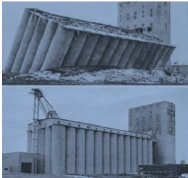
Figure: Le désastre du silo de Transcona, Canada
