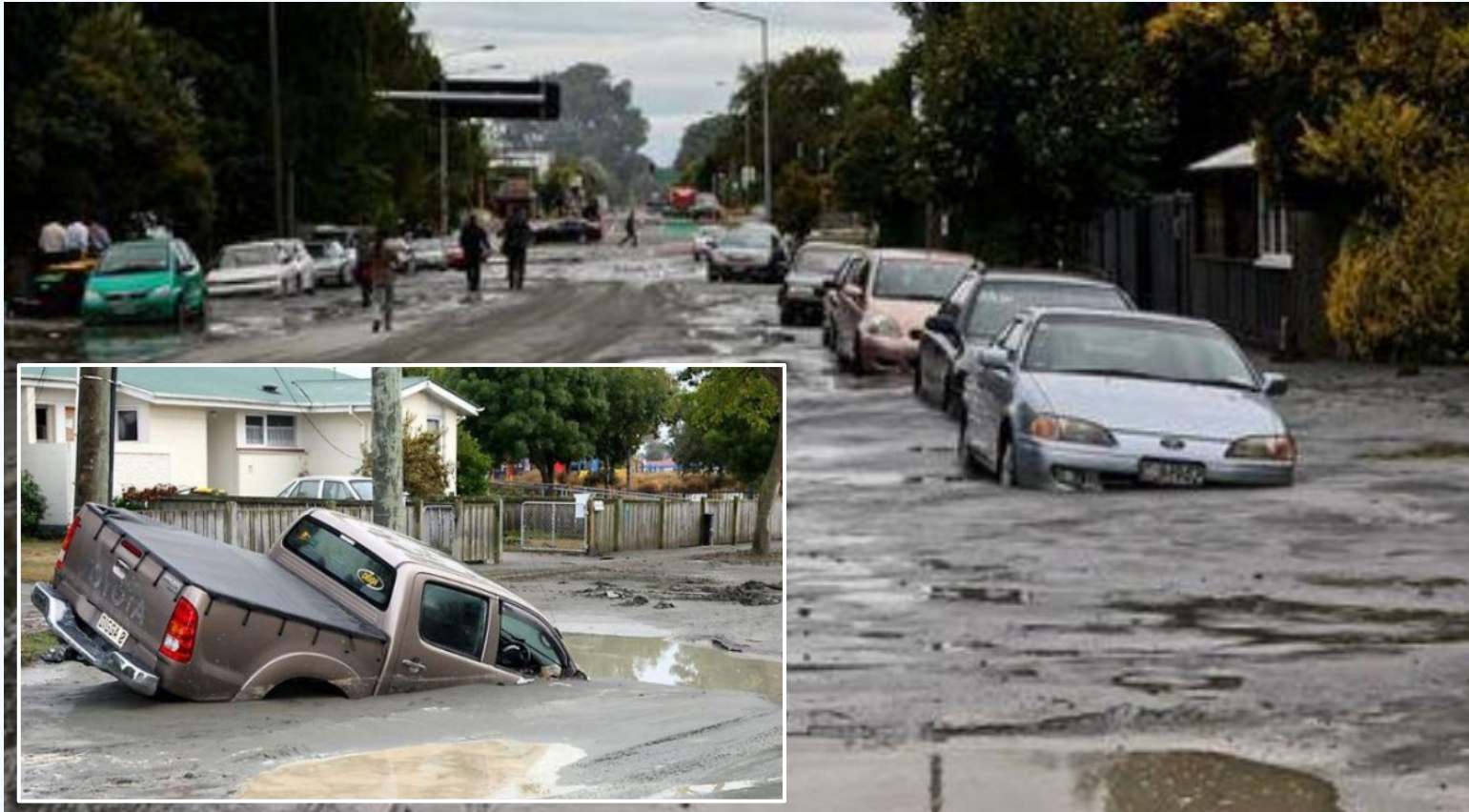
Effet de la liquéfaction des sols sur les chaussées de Christchurch en Nouvelle Zélande (Christchurch Earthquake, New Zealand, 22/02/2011, Mw =6.6)
