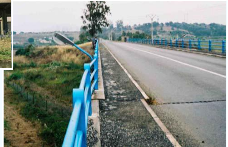
Déplacement transversal du tablier d'un pont routier
