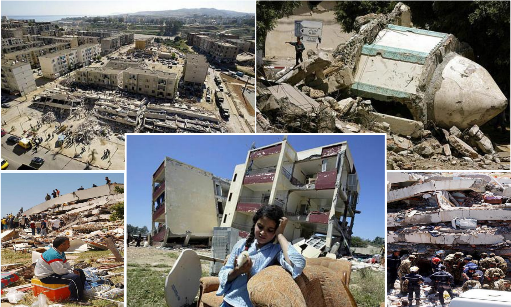
Exemples de dommages causés par le séisme de Boumerdès
