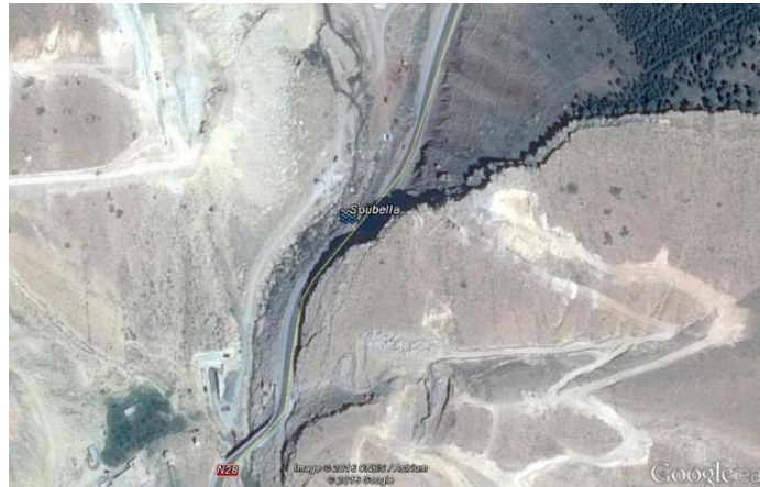
Figure 1.1 : Lieu d'implantation du barrage de Soubella à Magra wilaya de Msila
