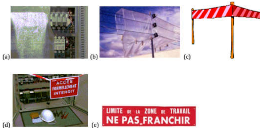
Figure III.30 : protections temporaires par écran(a), nappes, capuchons et pinces (b), balisage (c), (d) et signalisation (d) et (e)
