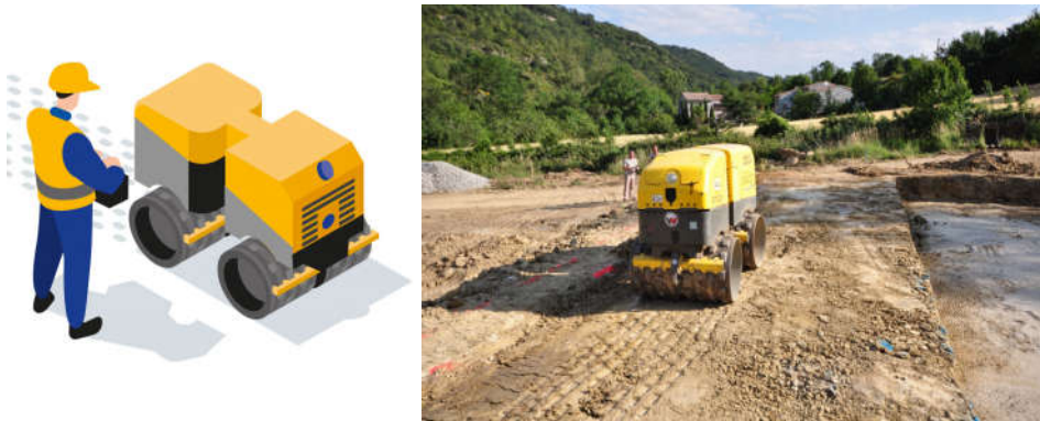
Figure IV.10 : Réduction des vibrations par utilisation d'engins téléguidés
