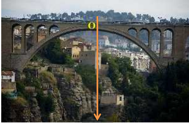
الشكل (1) جسر سيدي راشد
